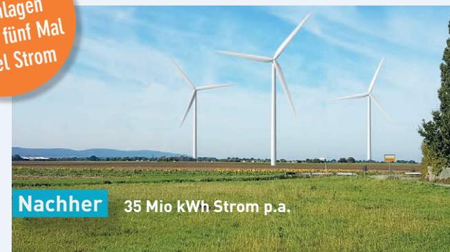
Nachher 3 moderne Anlagen mit 17,1 MW Leistung
